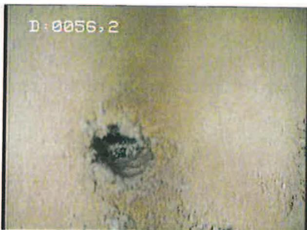
**Perforations avec développements bactériens qui réduisent la section des ouvertures.**
