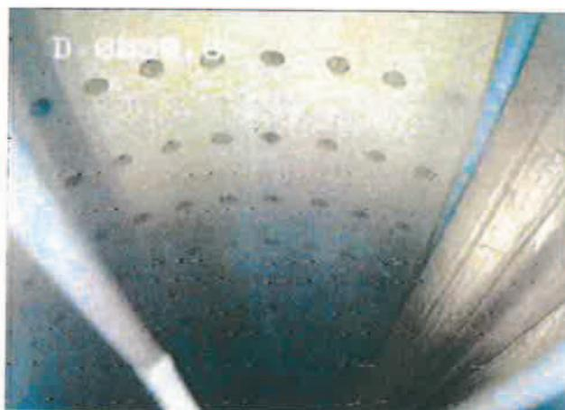
**Deuxième zone lanternée entre 51,1m et 51,6m avec perforations bien ouvertes et avec une génératrice du puits plus encombrée de dépôts.**
