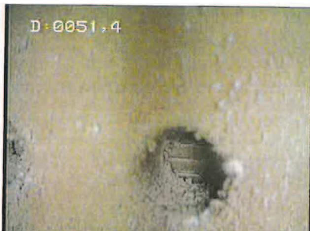
**Perforations bien ouvertes avec filtres partiellement encombrés de fines rousses.**
