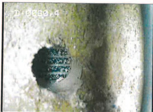
**Perforations assez bien ouvertes avec colmatage partiel des filtres.**
